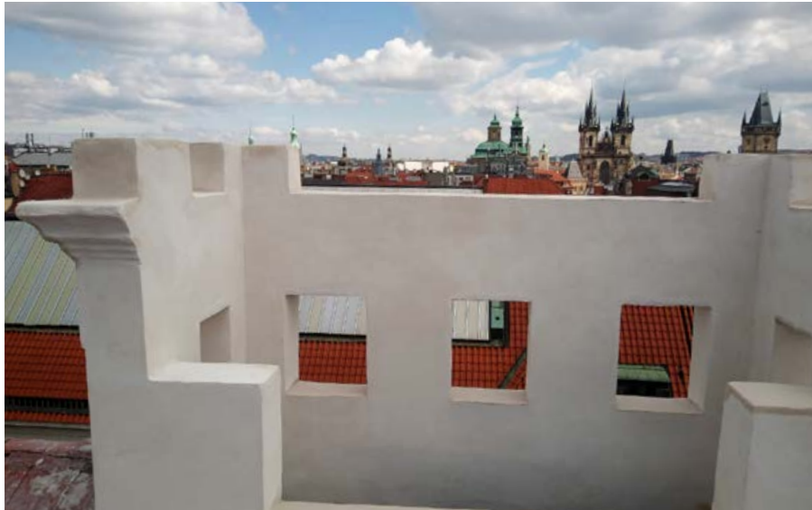
Výhled ze střechy SLÚ.
